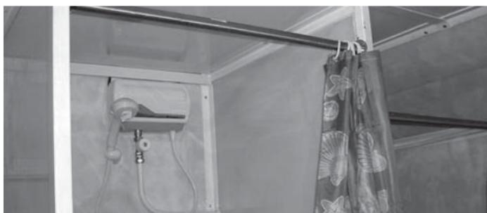
Оборудование мобильных кабин: тепловая завеса, насос и проточный водонагреватель.
